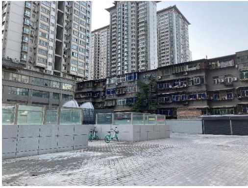
西关正街站风亭、冷却塔
