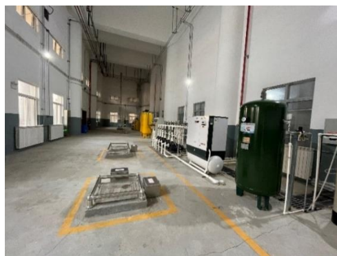
洗车废水回用处理装置
