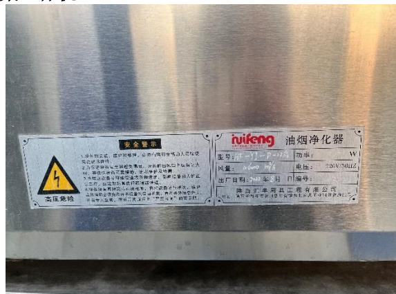
停车场食堂油烟净化器铭牌
