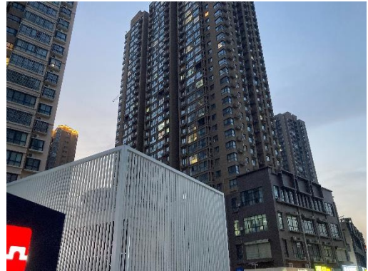
纺二路站冷却塔
