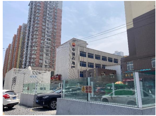
卫星测控中心站风亭、冷却塔
