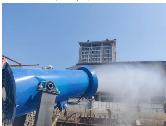
安定门站定时洒水降尘
