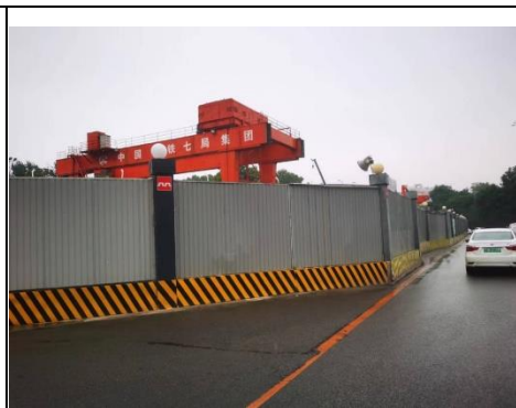
TJSG-20 标施工区域边界设置的硬质围挡
