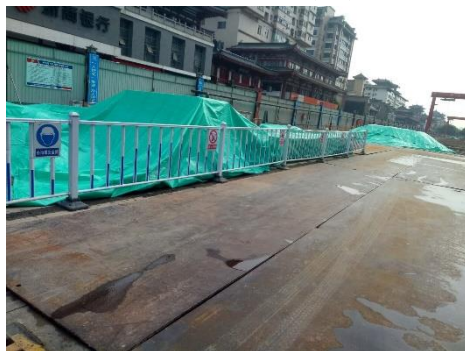
施工场地整洁
