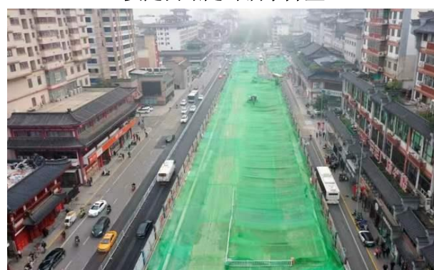
TJSG-15 标渣土遮盖
