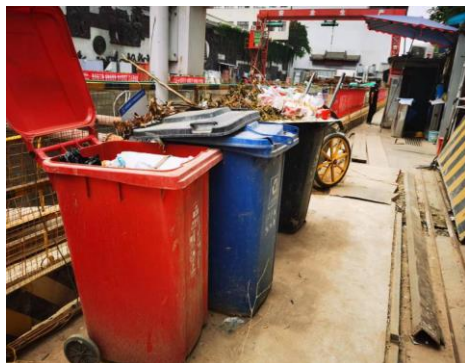
施工现场配备的垃圾收集设施
