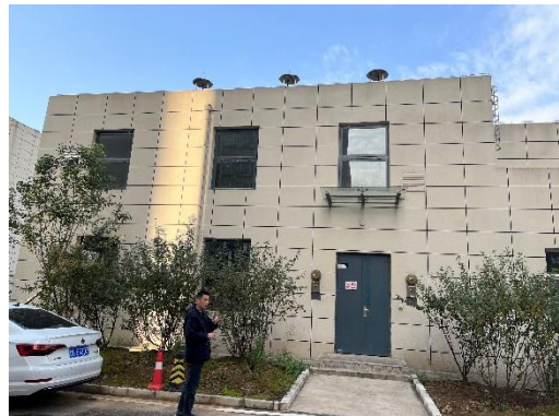
锅炉房钢结构大门
