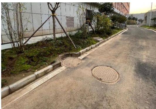
纺织城停车场食堂隔油池
