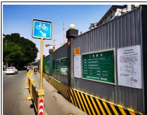
TJSG-14 标施工区域边界设置的硬质围挡
