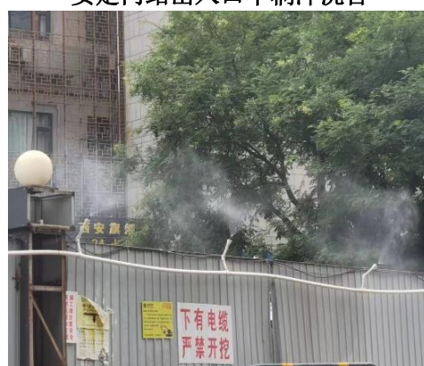
安定门站定时洒水降尘
