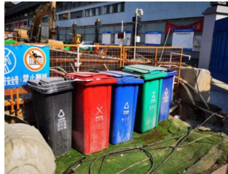
出入口施工场区垃圾收集设施
