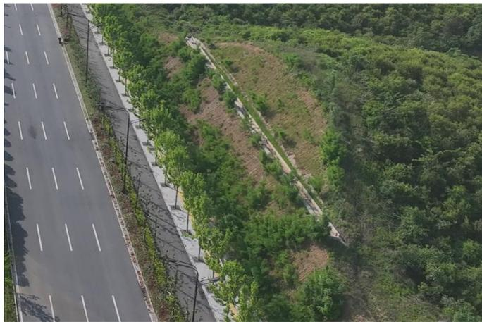
图 7-5 大别山路连接线工程护坡、截水沟
