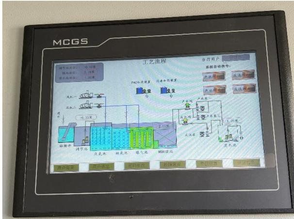
图 7-11 收费站污水处理设备处理流程
