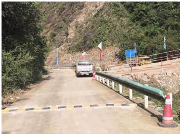
施工便道硬化
