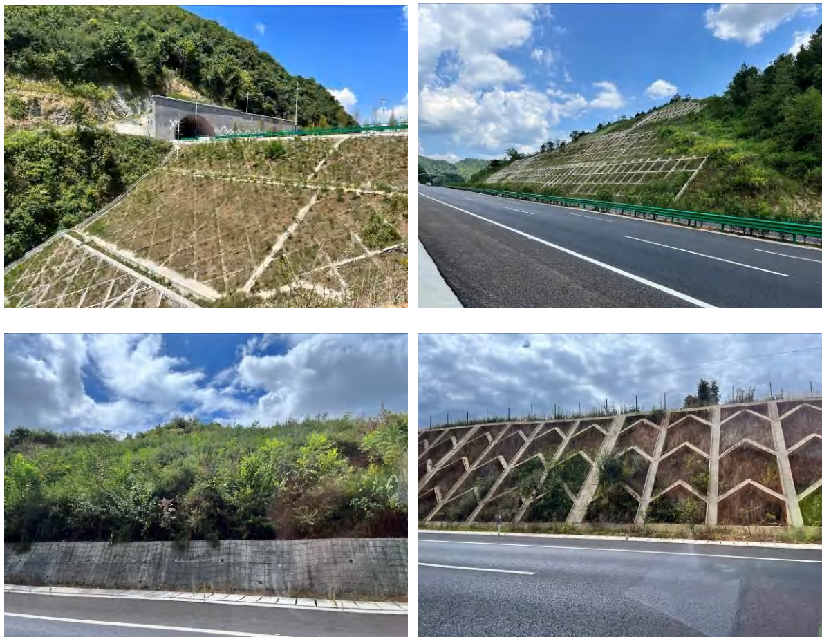
边坡防护工程
